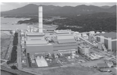
中国電力三隅発電所 (1号機、2号機)
