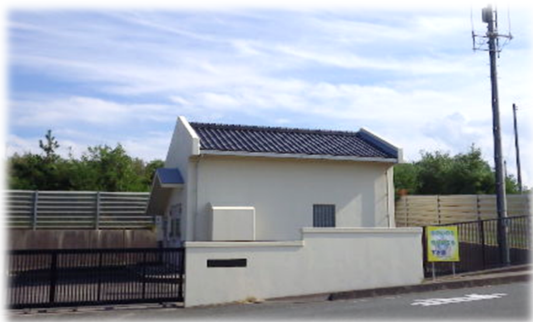
【国府処理区 唐鐘ポンプ場】
