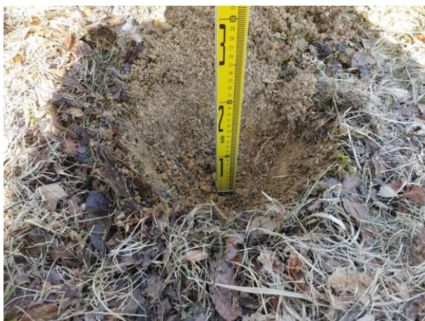
標準掘削状況
