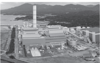
中国電力三隅発電所 (1号機、2号機)
