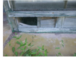
土台の腐朽
