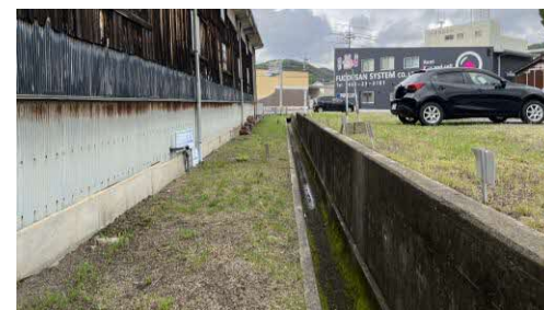
水路及び擁壁の状況
