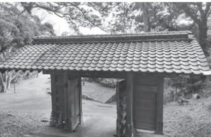
旧浜田県庁表門改修
