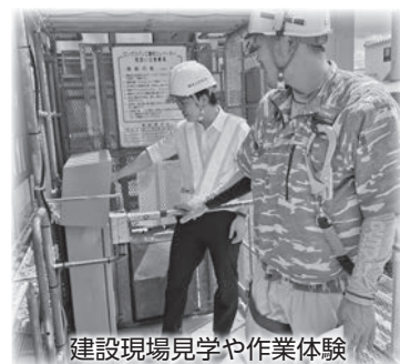
建設現場見学や作業体験
