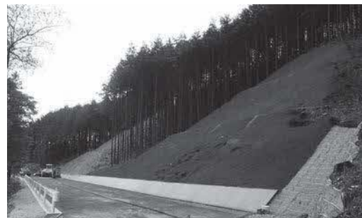
旭町重富地区での道路整備 (市道の拡幅工事)
