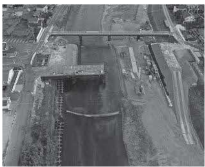
周布橋の架け替え工事
