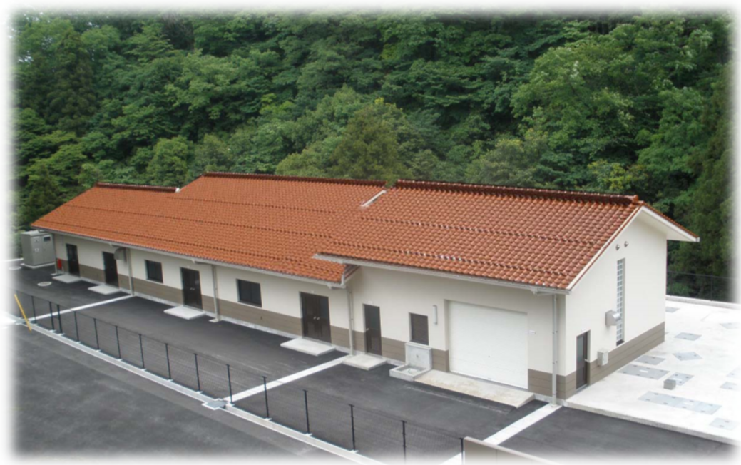
【雲城地区污水处理場】
