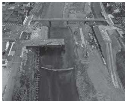
周布橋の架け替え工事
