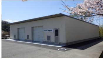
防災備蓄倉庫整備事業 （令和4年度事業費 4,550万円）
