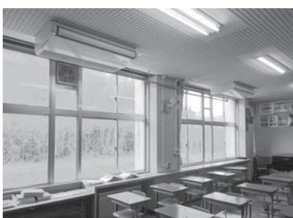
特別教室のエアコン設置
