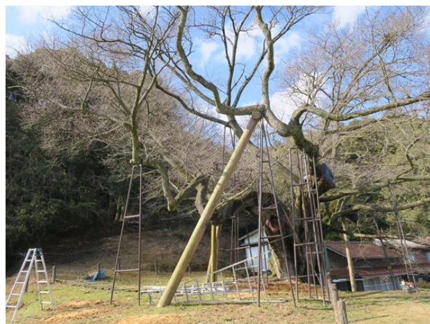
切り戻し後の状況
