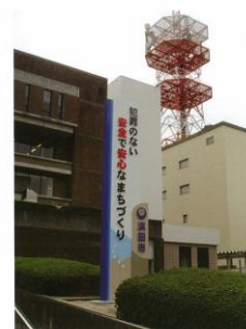
安全安心まちづくり啓発広告塔 「浜田市役所前」 平成20年3月31日除幕
