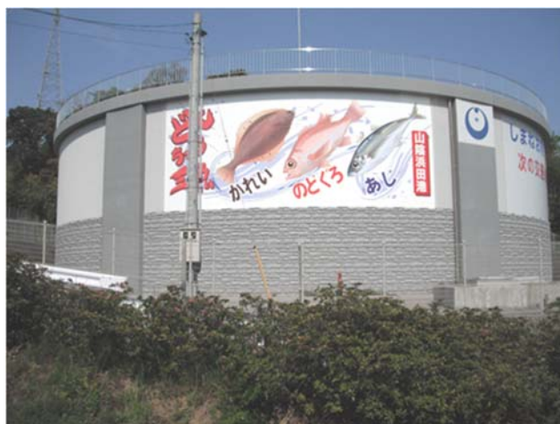
竹迫配水池(平成20年度完成 有効容量6,000m 3 )
