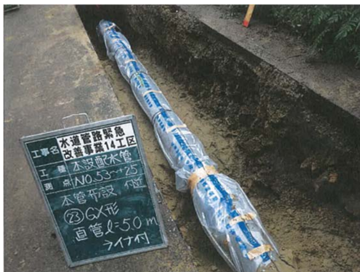
耐震管布設状況写真
