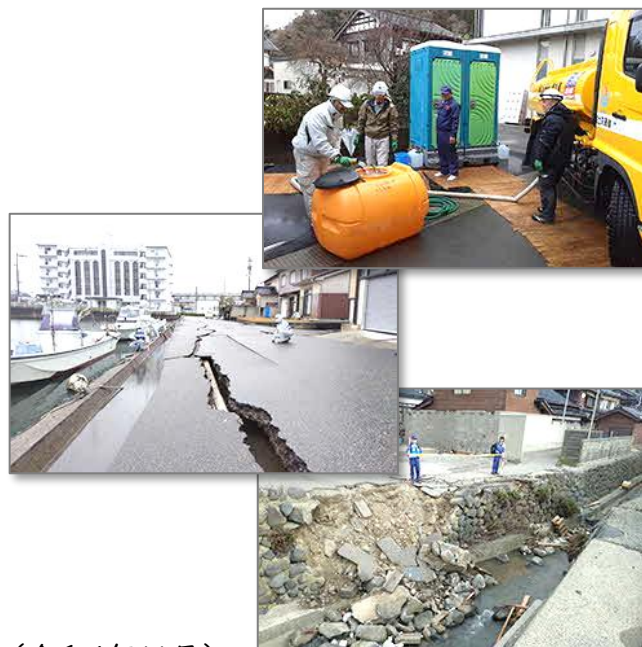
R6.1 能登半島震災の現地写真
