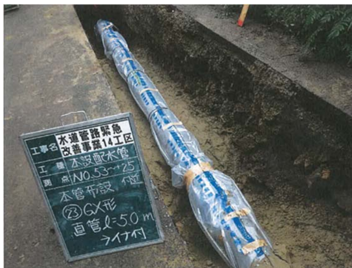
耐震管布設状況写真
