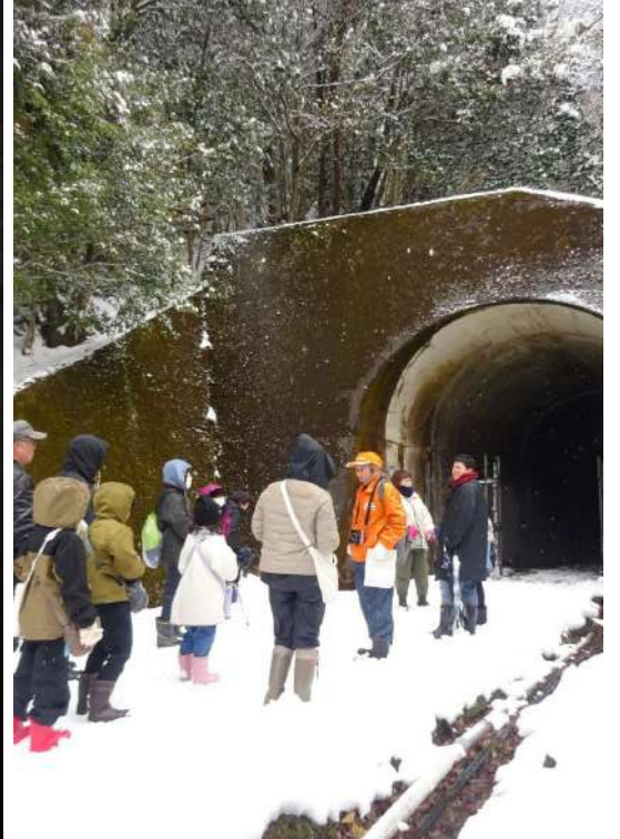
下長屋トンネル(新線)
