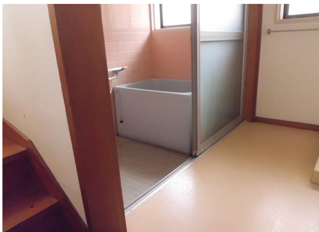
1階 (風呂場・洗面所・トイレ・階段)
