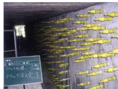
写真 4－2 ひび割れ注入状況
