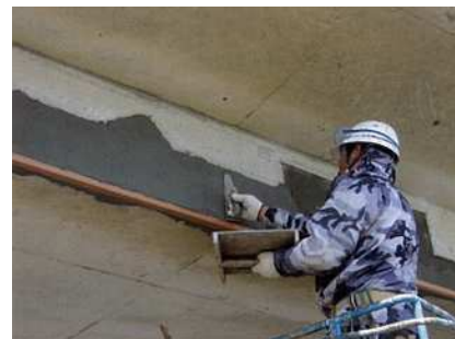
写真 4－3 断面修復状況
