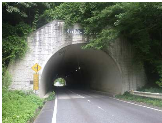
小山トンネル（那賀西部広域農道）
