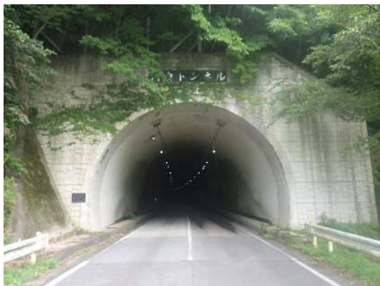
河内トンネル（那賀西部広域農道）
