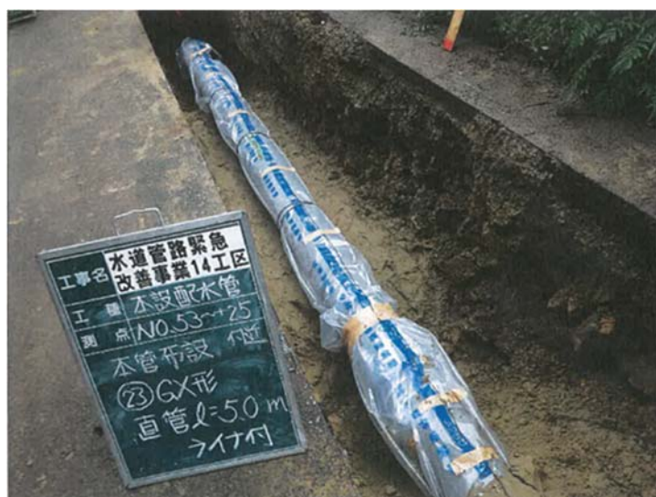
耐震管布設状況写真
