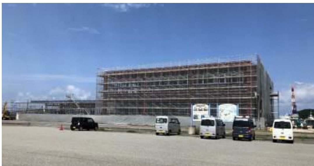
【参考】7号荷さばき所の整備状況写真（令和元年8月30日現在）
