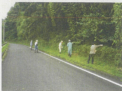
広域防護柵へ巻き付いたつる性植物への除草剤の散布 (2017/7/19)
