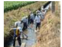
水路の泥上げ
