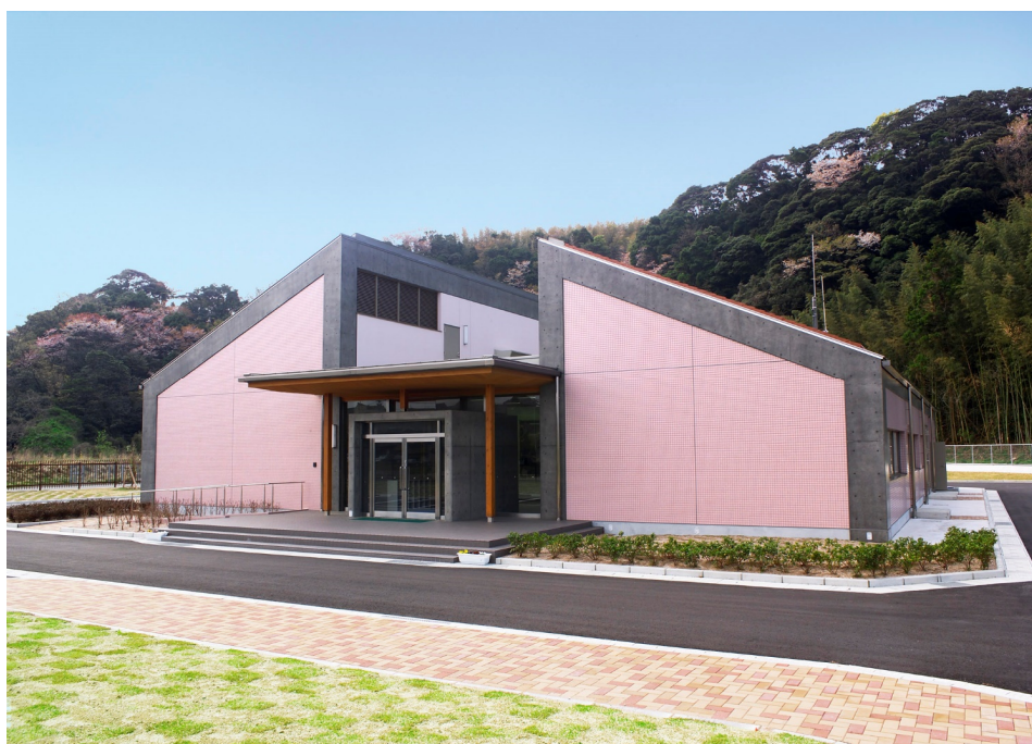
【国府浄化センター】
