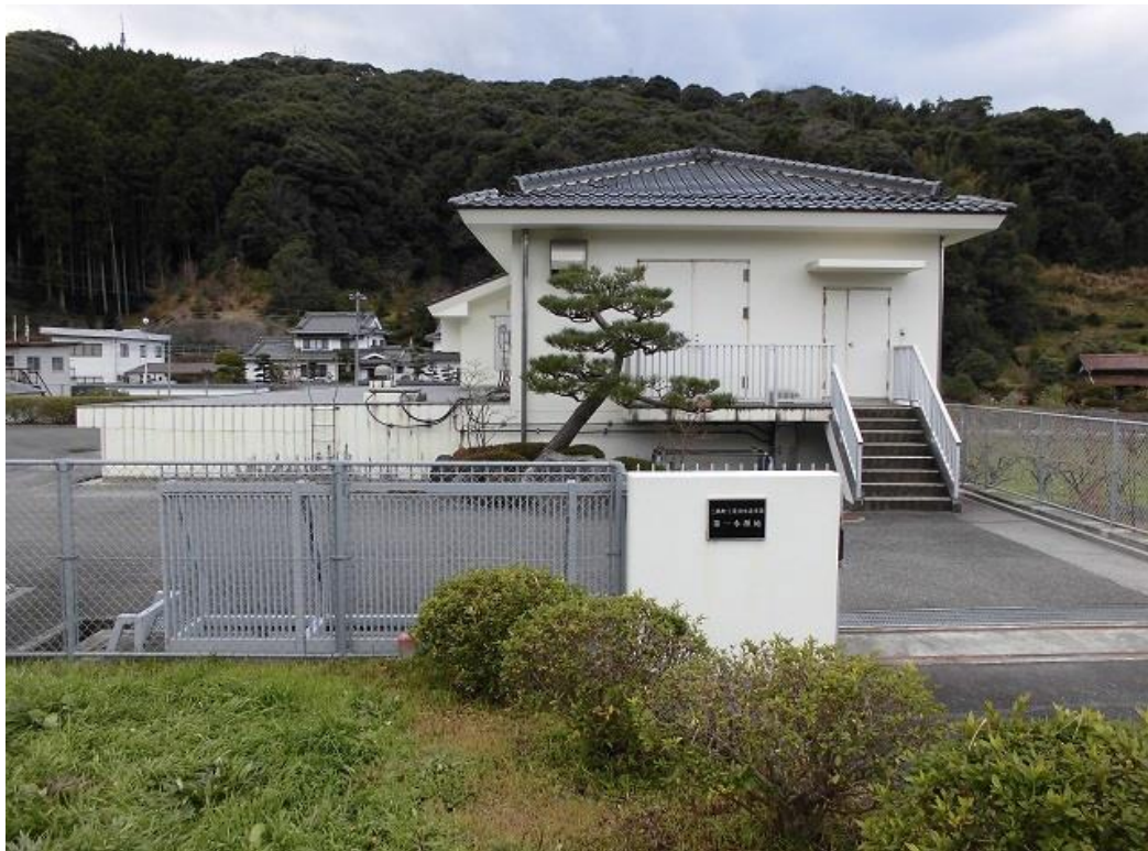
浜田市工業用水道事業 第1水源地
