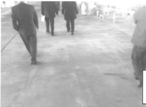
唐津魚市場のコーティングされた床面を視察
