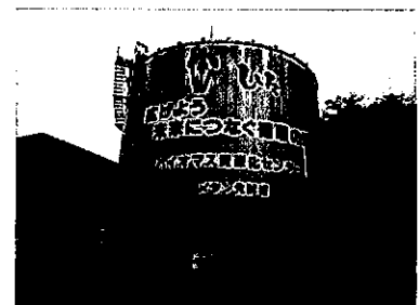
3・メタン発酵槽
