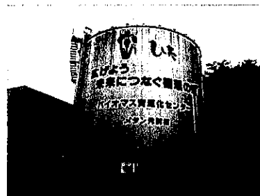
3・メタン発酵槽
