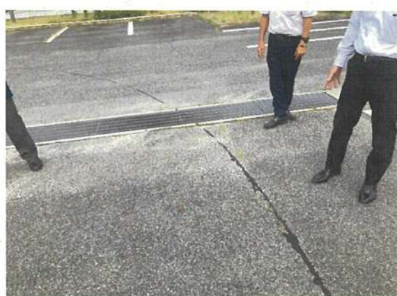
誘導線が埋め込まれた跡（道の駅）
