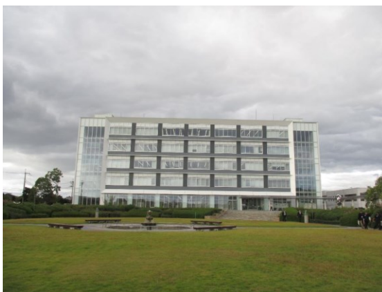
加東役所正面玄関(噴水広場)
