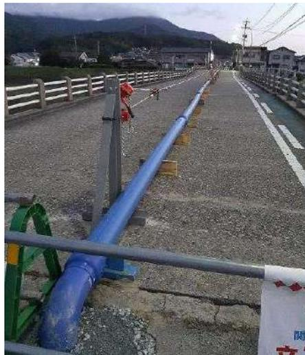
3 三階町地内（配水管 ダクタイトル鉄管 φ100 mm 2003年設置）
