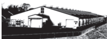
▲生湯町にある中間処理施設
