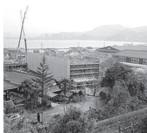
新校舎建設中の長浜小学校
