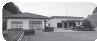
老朽化が著しい浜田市火葬場
