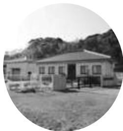
三保三隅浄化センター
