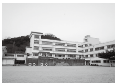
▲耐震化工事が完了した石見小学校舎
