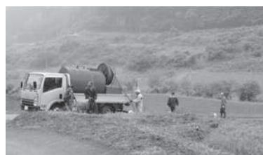
センチピードグラス吹付け機による作業風景
