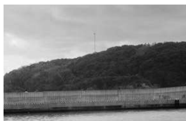
災害時情報伝達手段のラジオ放送用アンテナ（馬島）
