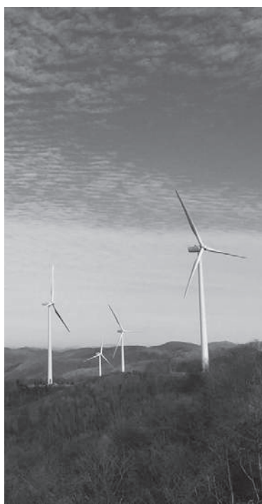
現在稼働中の風力発電機
