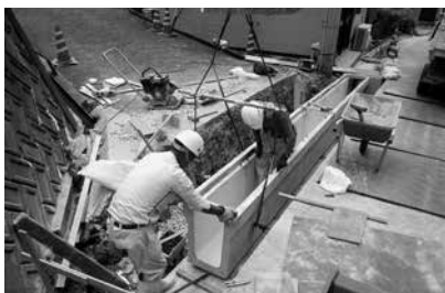
市街地での側溝整備
