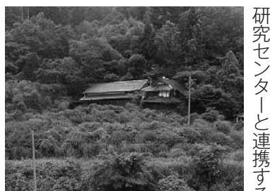
崩壊した集落の空き家
