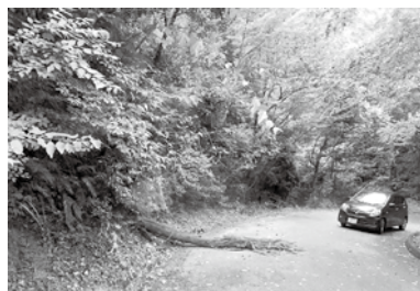
風雨時に道路に倒壊した危険木
