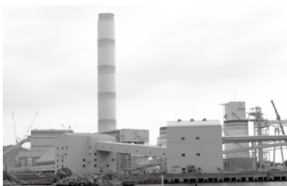
中国電力三隅火力発電所
