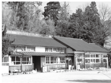
施設改修前の井野小学校教室谷分校
