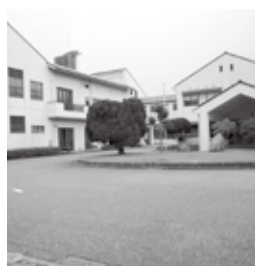
改良工事される浜田浄苑
