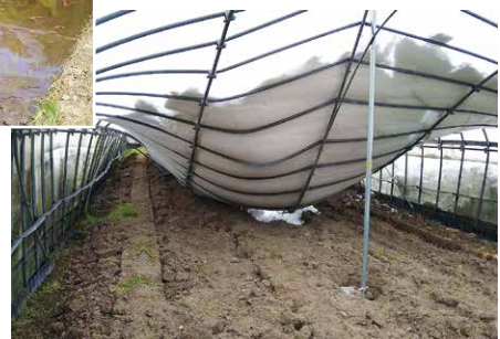
雪で倒壊したビニールハウス
