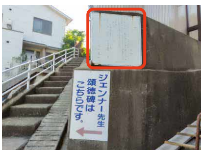
劣化が進む田町の看板
