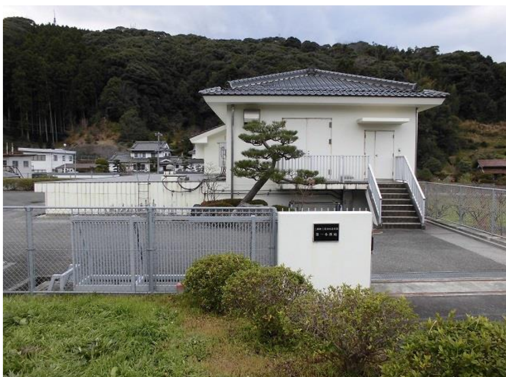
浜田市工業用水道事業 第1水源地
