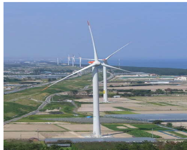
* 北条砂丘風力発電所（1,500KW 9基 平成17年11月完成）
