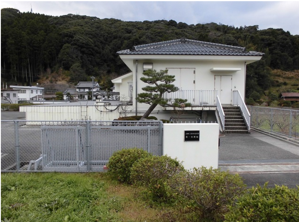
浜田市工業用水道事業 第1水源地
