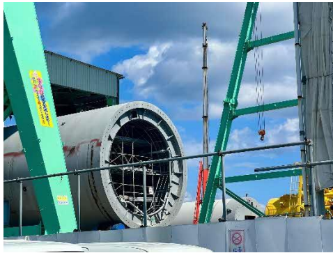
岸壁で組立中の浮体下部
